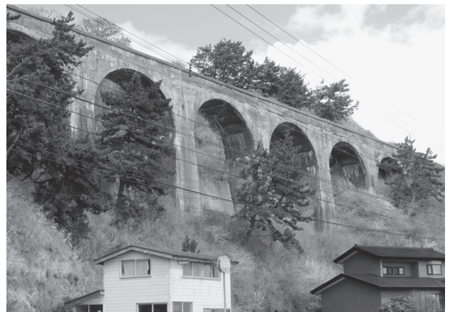
汐首地域に残る旧戸井線のアーチ橋
